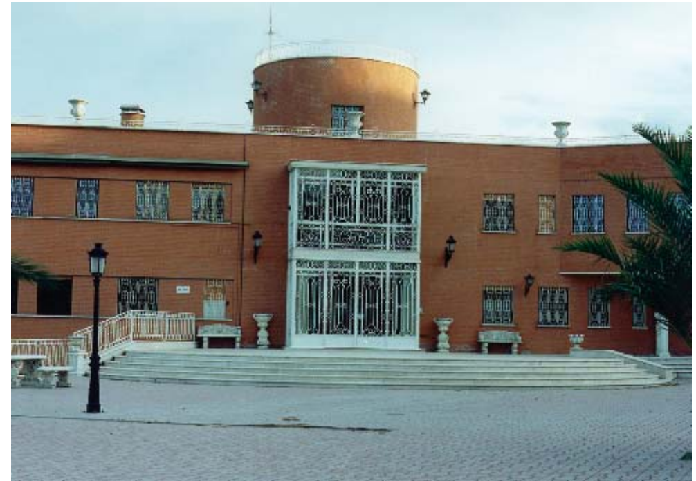
Fachada de la Casa de Apostolado de San Pedro Apóstol en Roma.
